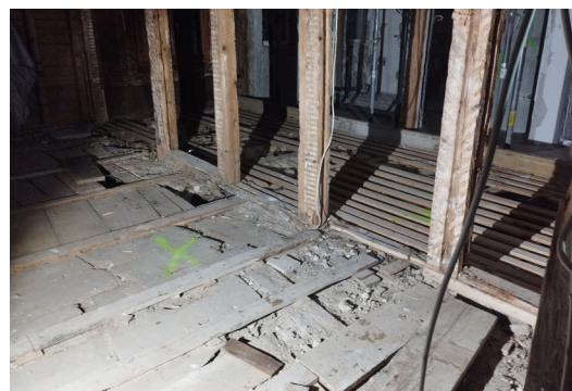
Baufällige Kellerdecke und Träger.
