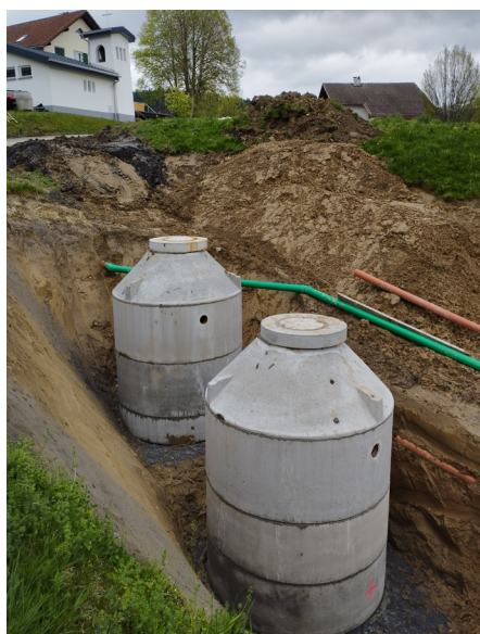
Kleinkläranlagen in Außenparzellen
