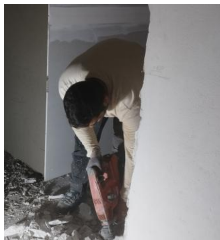
Auch das WC wird saniert.
